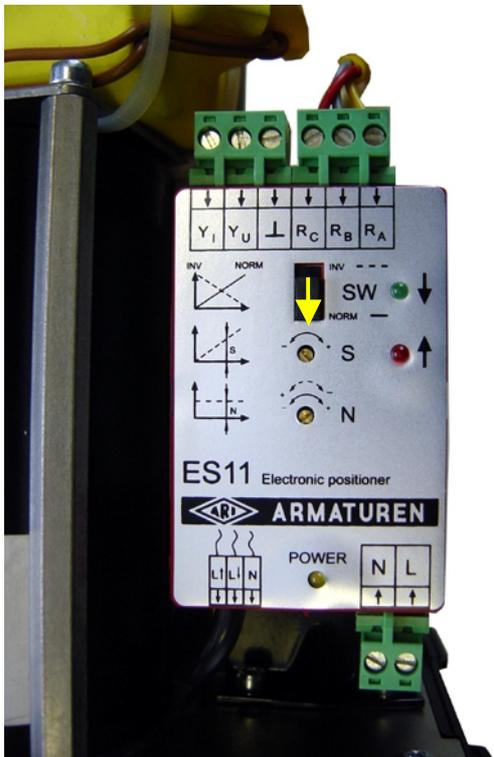
12). При настройке крайних положений следует обращать внимание на то, чтобы при соответствующем управляющем сигнале с контроллера шток надежно становился в заданное положение (полностью открывался или закрывался), но при малейшем изменении управляющего сигнала шток сразу должен в движение, т.е. следует минимизировать зону нечувствительности на краях диапазона регулирования клапана.
